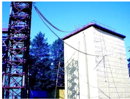
Рис. 3. Общий вид сверхвысоковольтного генератора стандартных коммутационных аperiodических импульсов напряжения U_{12}(t) временной формы T_m/T_p \approx 200 мкс/1990 мкс положительной (отрицательной) полярности типа ГКИН-2 на номинальное выходное электрическое напряжение до \pm 2 МВ отечественной разработки [18].
