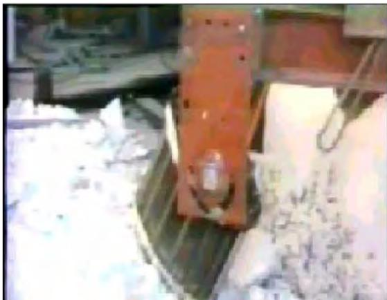
*Рис. 1. Общий вид разрушаемого ЭРГУК напыла бетона с первоначальным размером 1000X900X500 (высота) мм<sup>3</sup>.*
