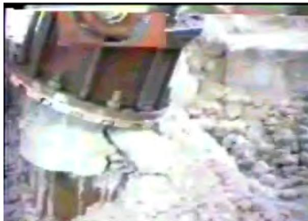
*Рис. 2. Щадящее разрушение (в последней фазе) слоя бетона над захороненным тонкостенным контейнером диаметром 450 и высотой 250 мм.*
